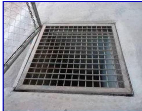
Figura 48. ATRP con cárcamo canaleta perimetral y con acceso restringido
